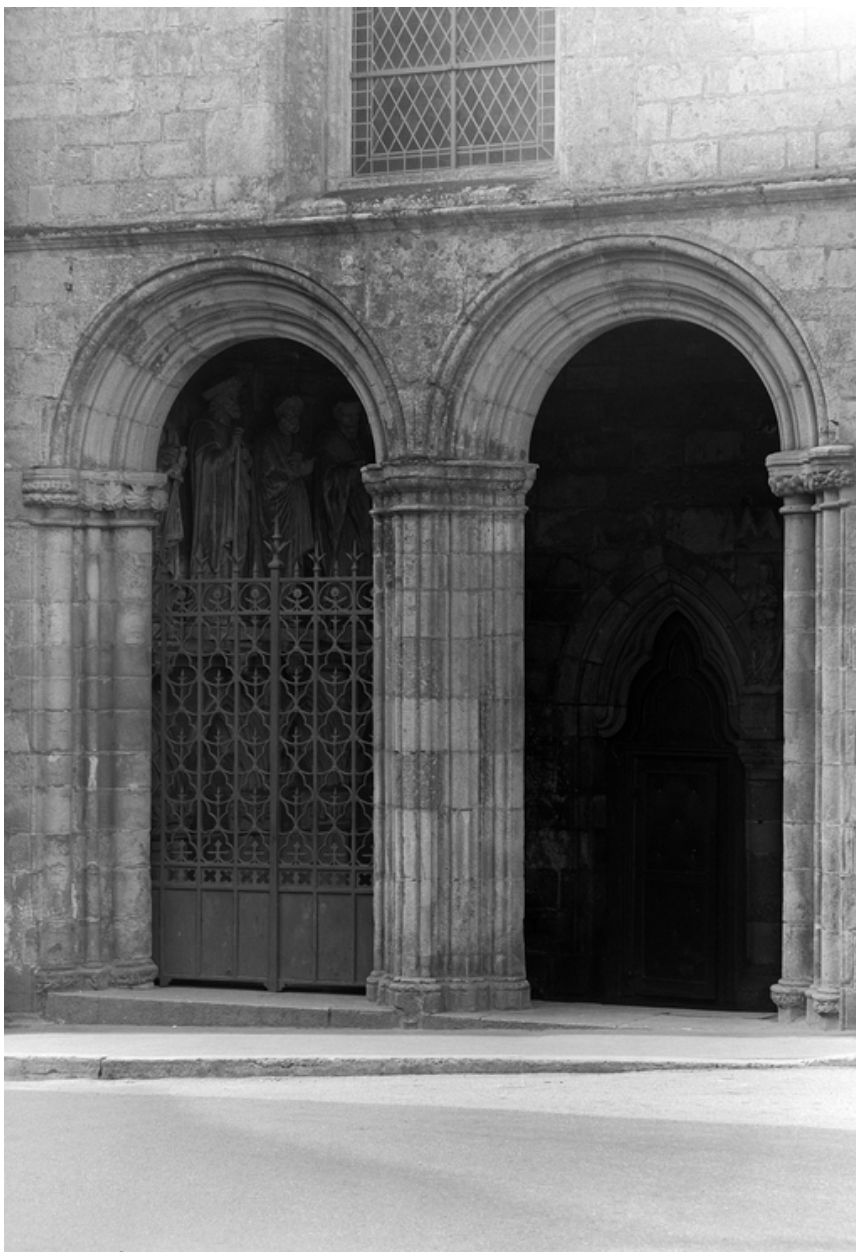
Façade sud, porche, face sud, 1er niveau : détail des ouvertures
