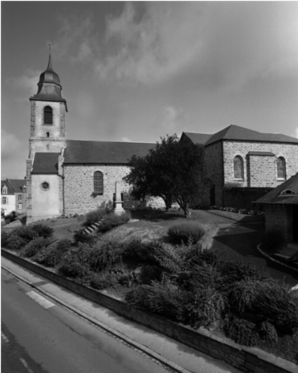
Elévation sud : vue générale
