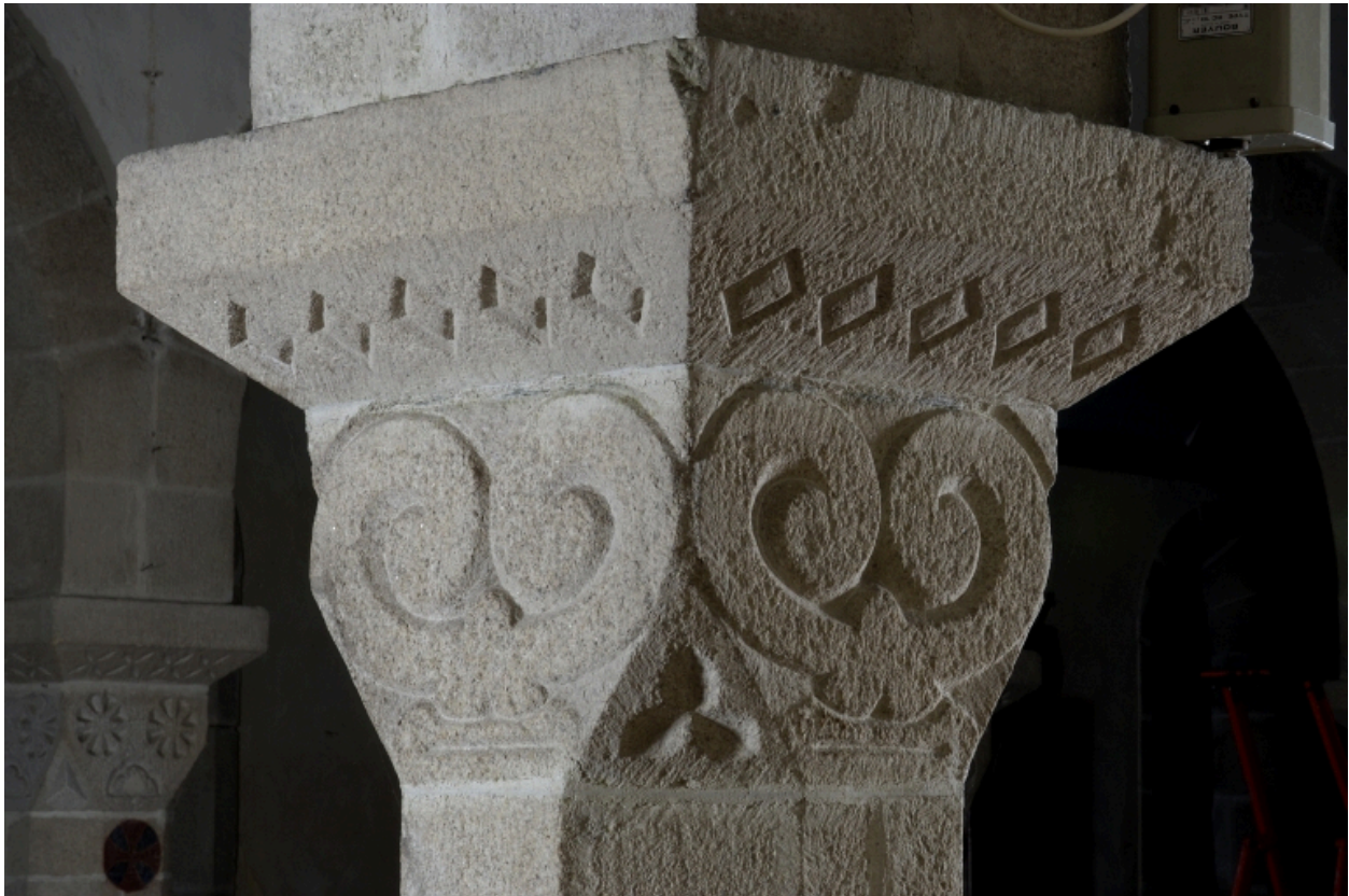
Locunolé, église paroissiale Saint-Guénoé : nef, chapiteau 5, état en 2004
