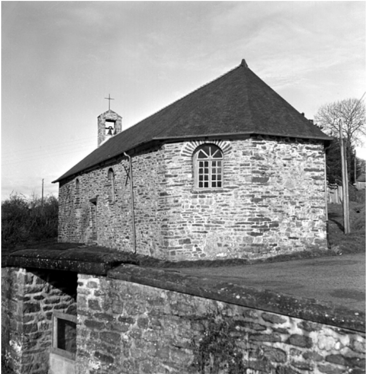
Vue générale est
