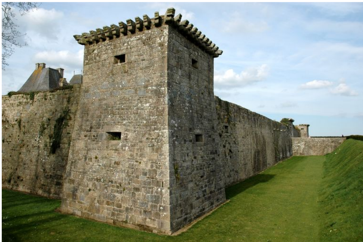
Vue de l'enceinte fortifiée du château de Kerjean
