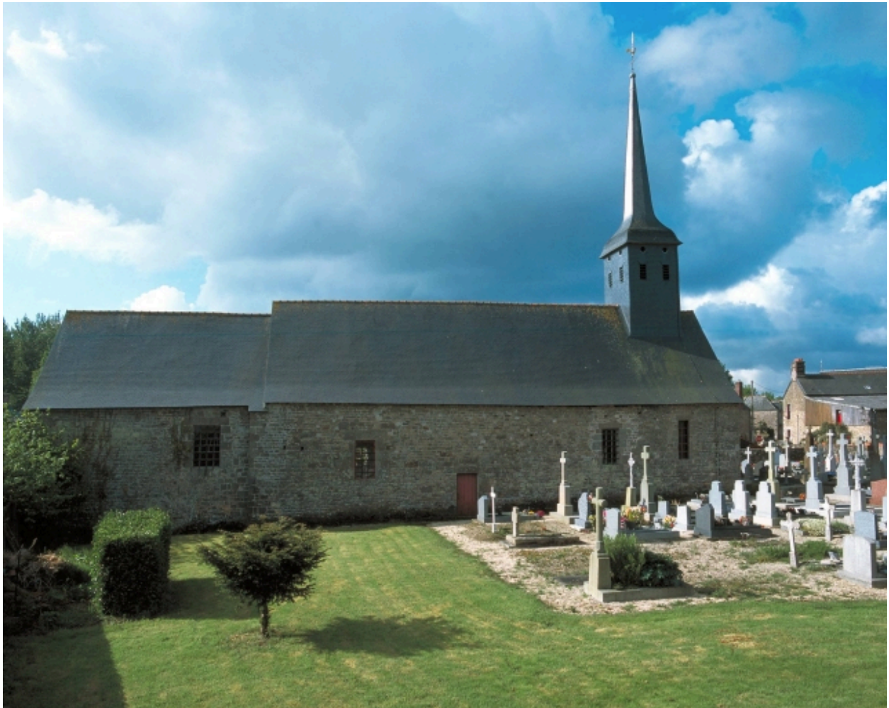
Vue générale nord
