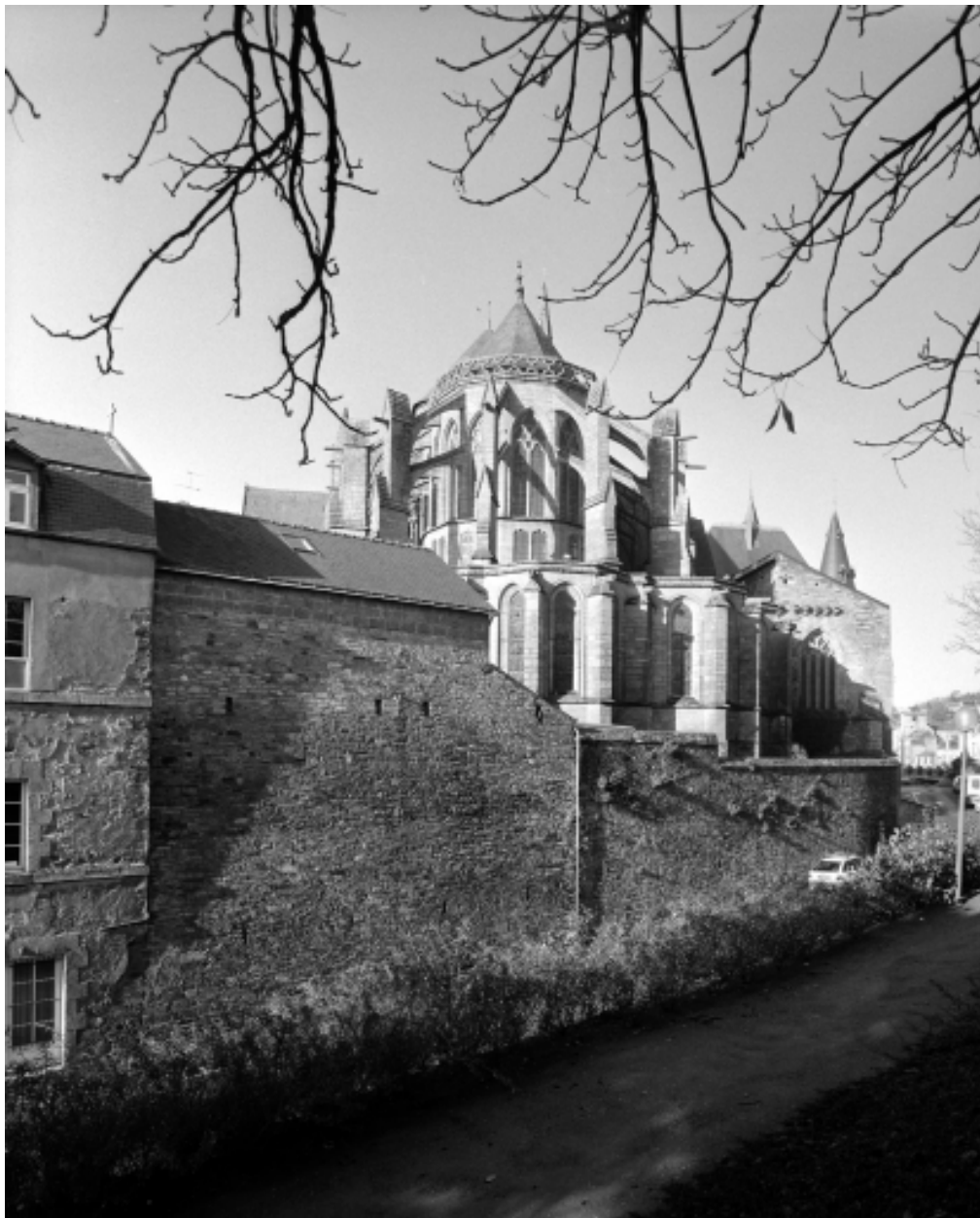
Elévation Est : vue générale
