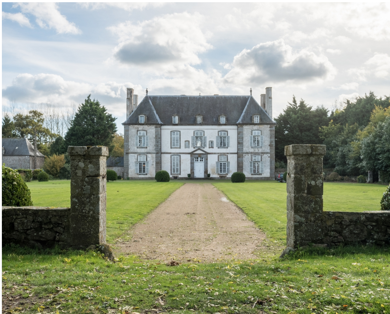
Façade nord-ouest, vue générale
