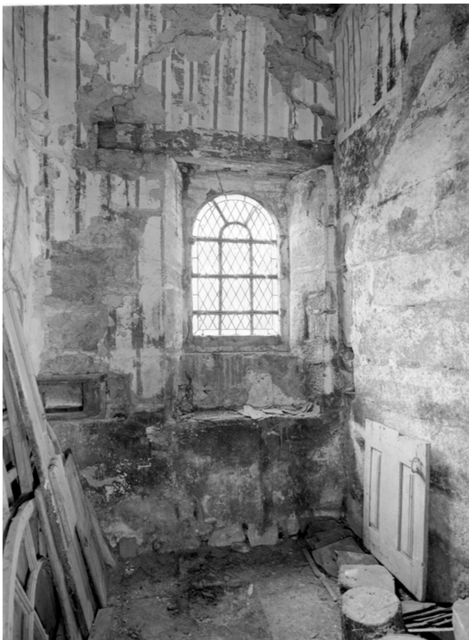
Intérieur de la chapelle des fonts : mur sud
