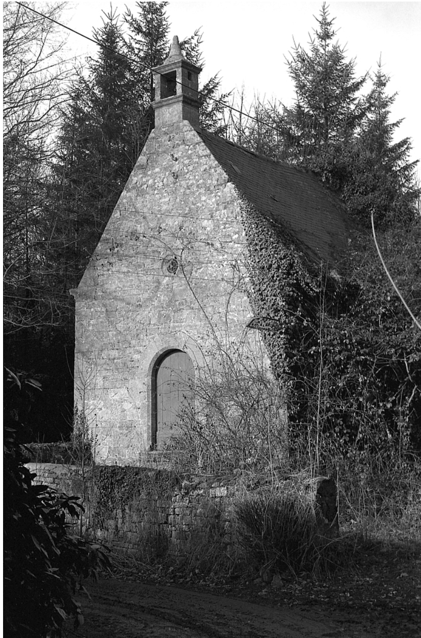
Chapelle Saint Etienne, état en 1979, élévation est, vue générale
