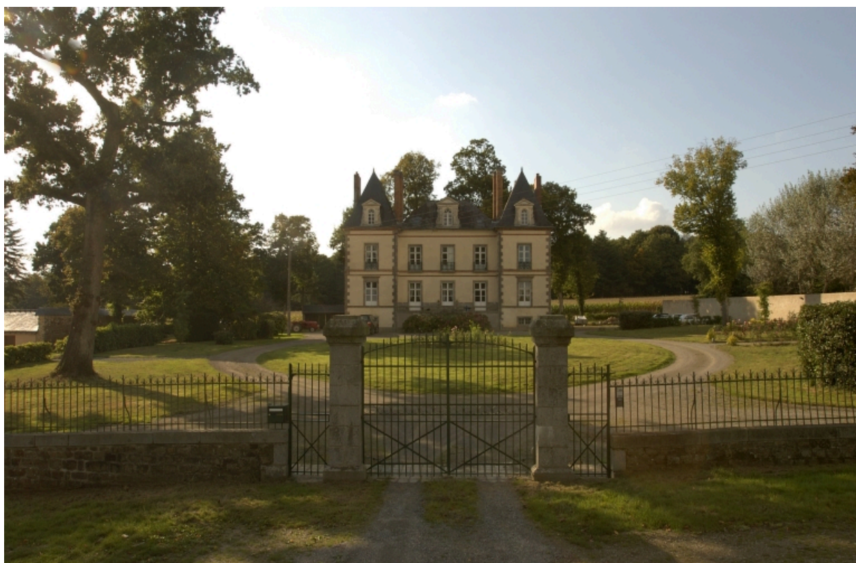
Vue de la façade du château
