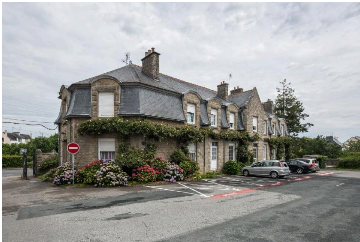
Façade sud de l'infirmerie (aujourd'hui logements). Georges-Robert Lefort, architecte, 1929. La partie est, à partir de l'avant-corps central, est un agrandissement de 1953.
