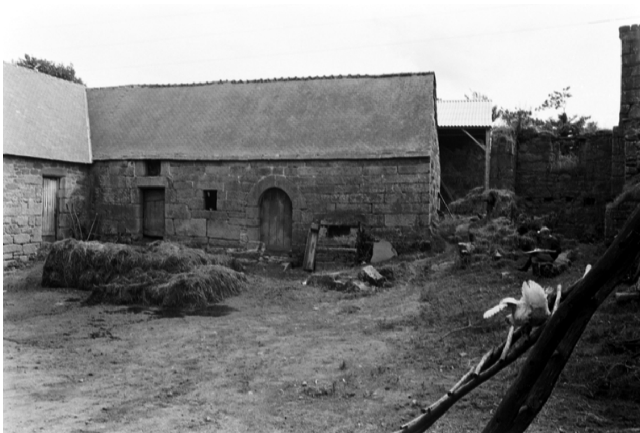
Face nord des communs sud et puits
