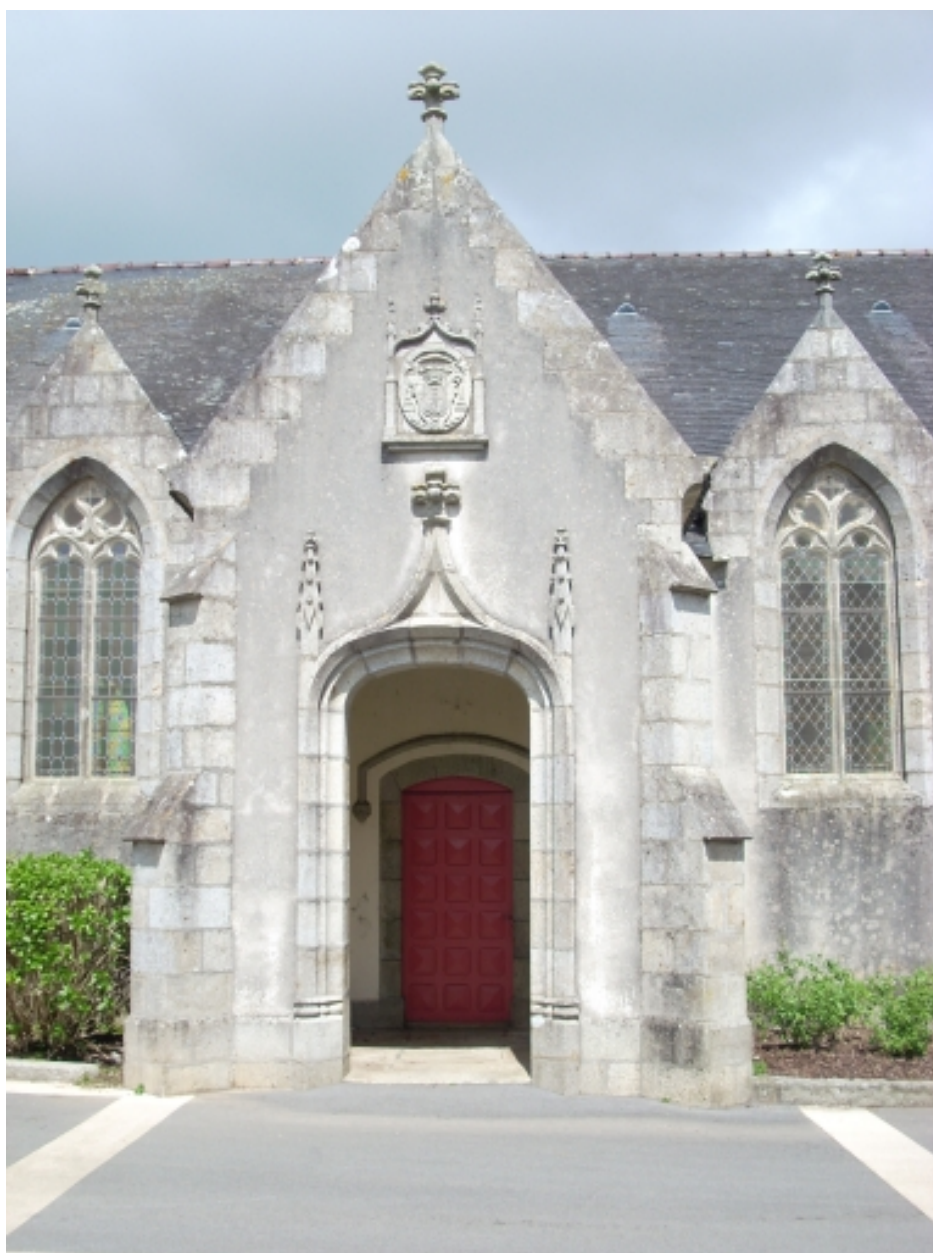
Plouyé, église paroissiale Saint-Joseph : porche sud
