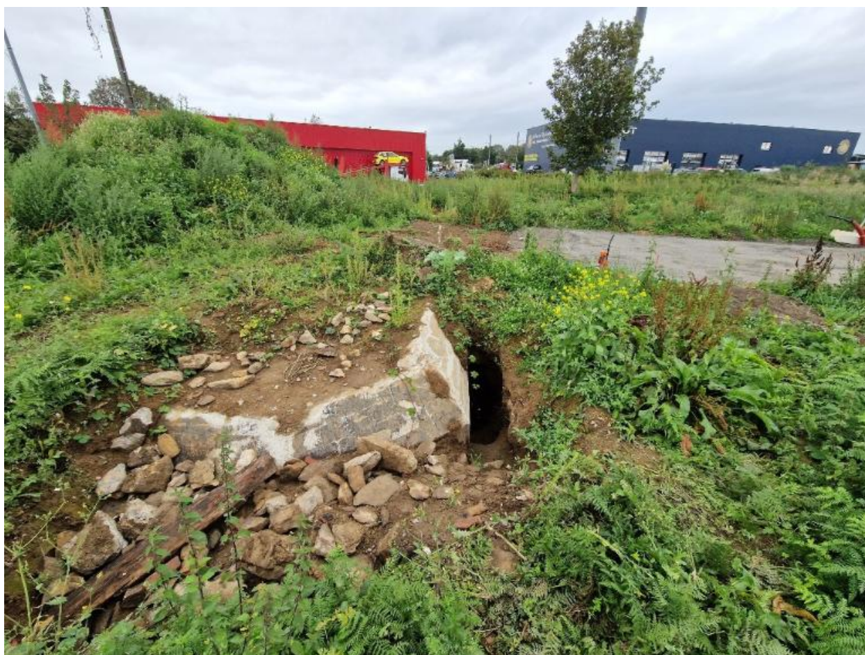
Vue de l'angle sud-est
