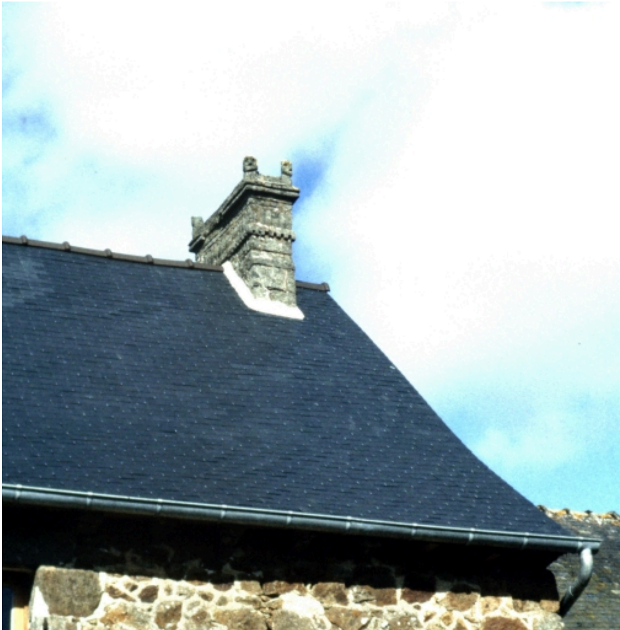
Le bourg, maison : souche de cheminée
