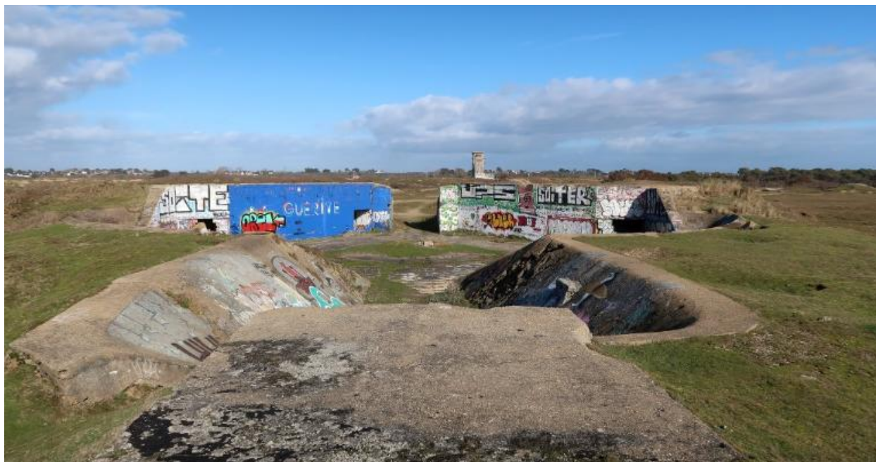
Vue du bunker - cuve nord pour canon de 34 cm avec magasins de munitions
