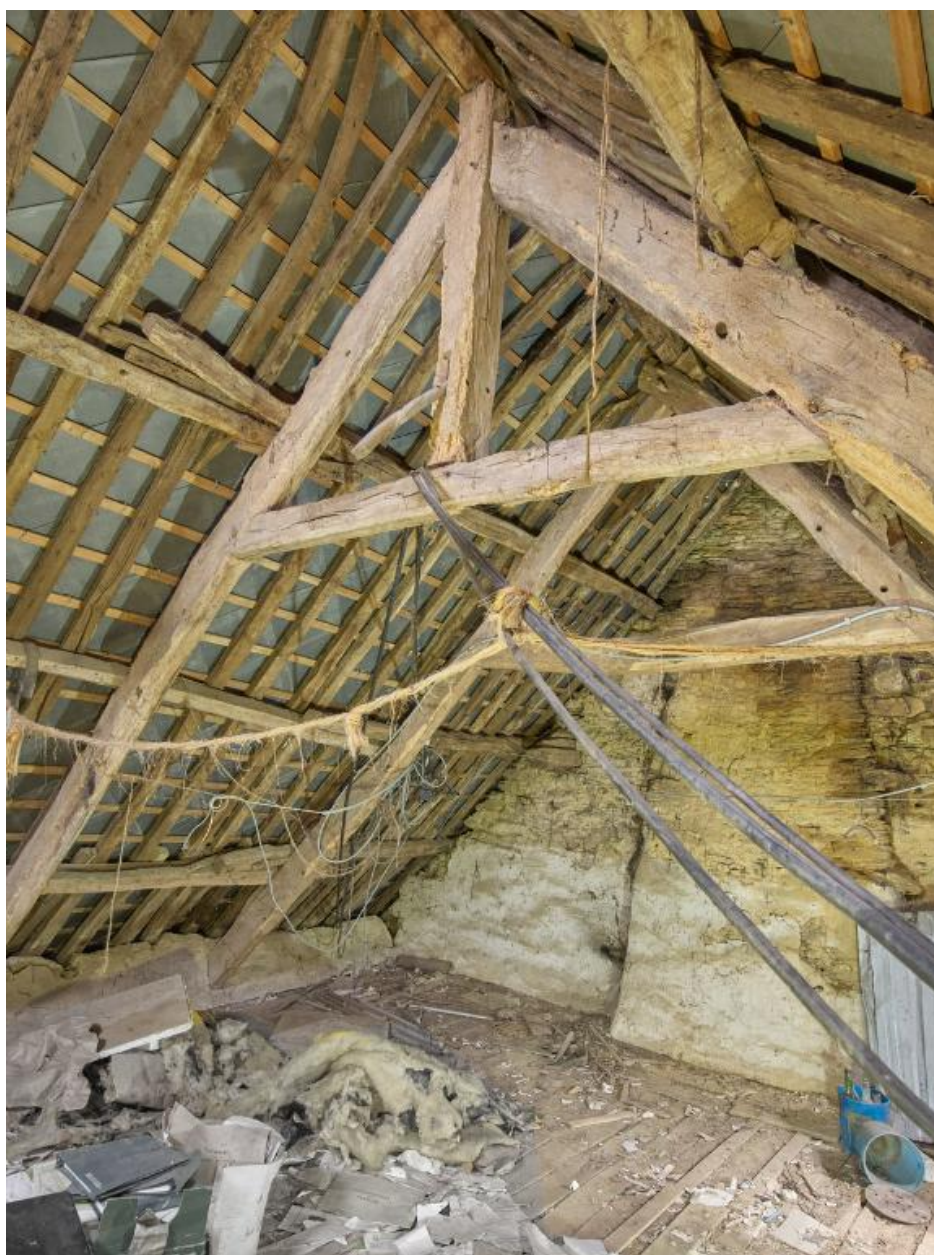
Logis 1673. Charpente du comble : fermes à entrain retroussé et poinçon court
