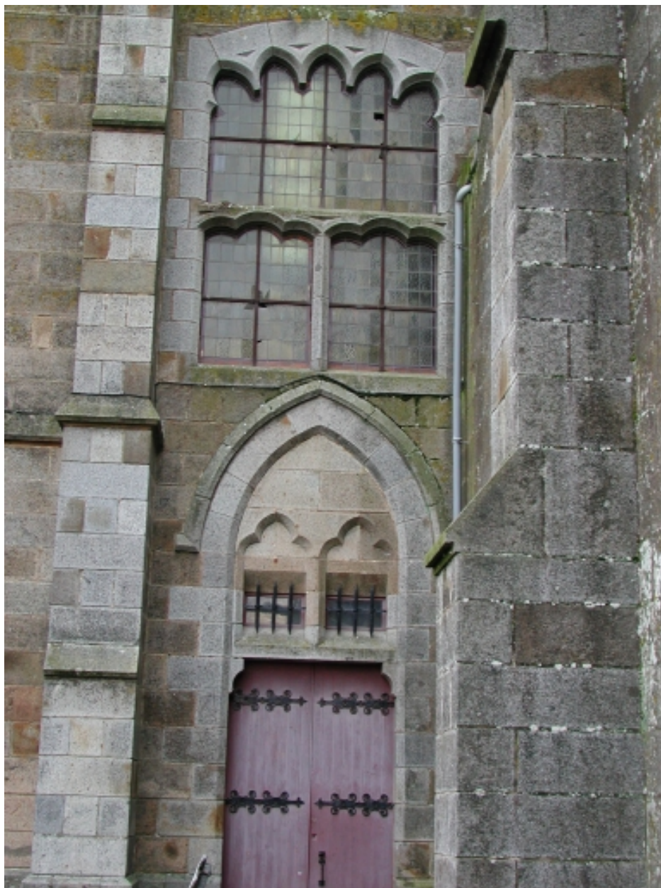
Vue partielle ouest du bras nord du transept
