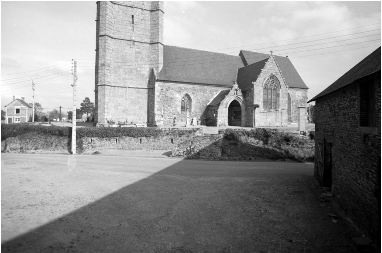
Façade sud, vue générale.
