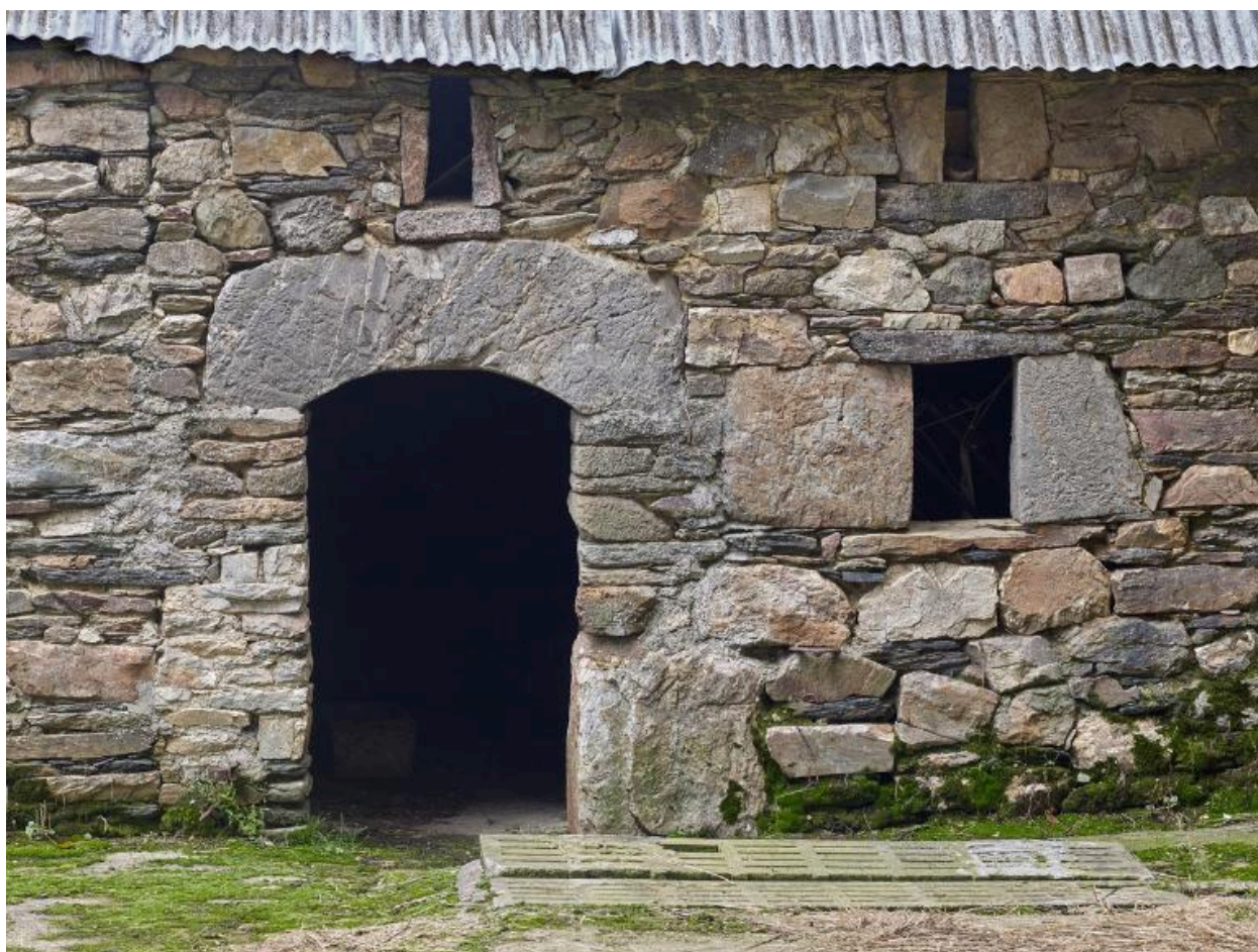
Logis à pièce unique de la 2e moitié du 18e siècle. Elévation sud-est. Détail des baies
