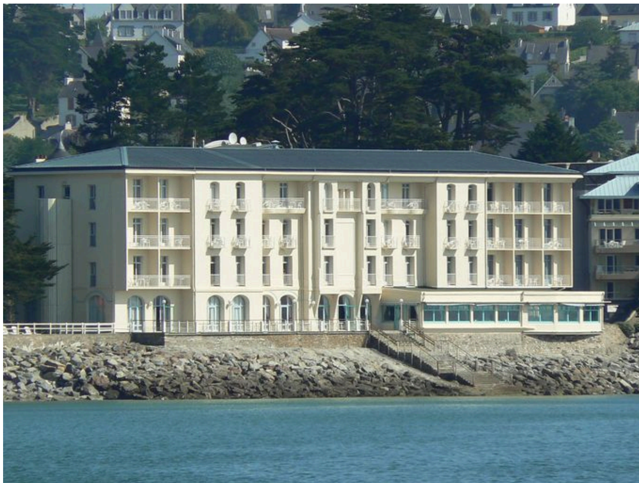
Vue générale du Grand Hôtel de la Mer de Morgat, côté plage
