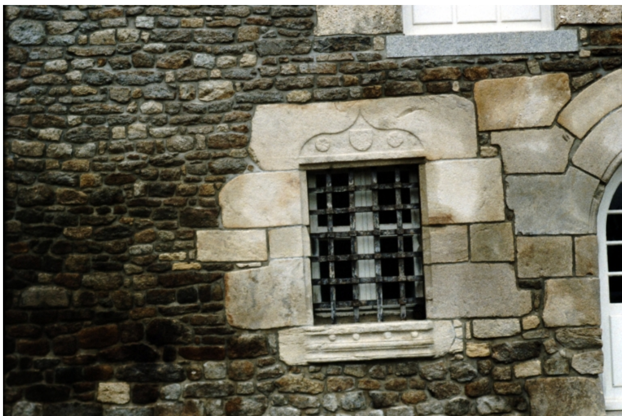
La Basse Biliais : élévation sud, détail
