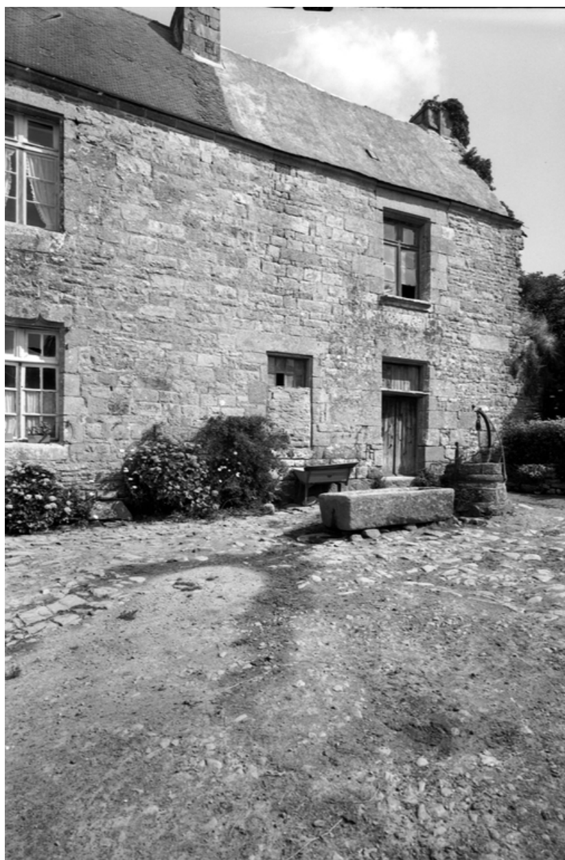
Façade sud du logis, détail partie est
