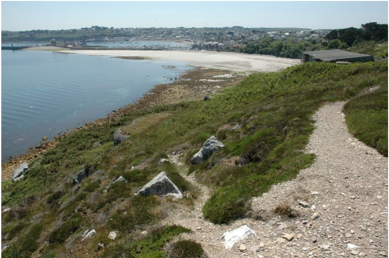
Vue du sentier côtier dominant le réduit de batterie de côte du Petit Gouin et les batteries de côte coiffées de deux bunkers - casemates de type 671 (état en 2005)
