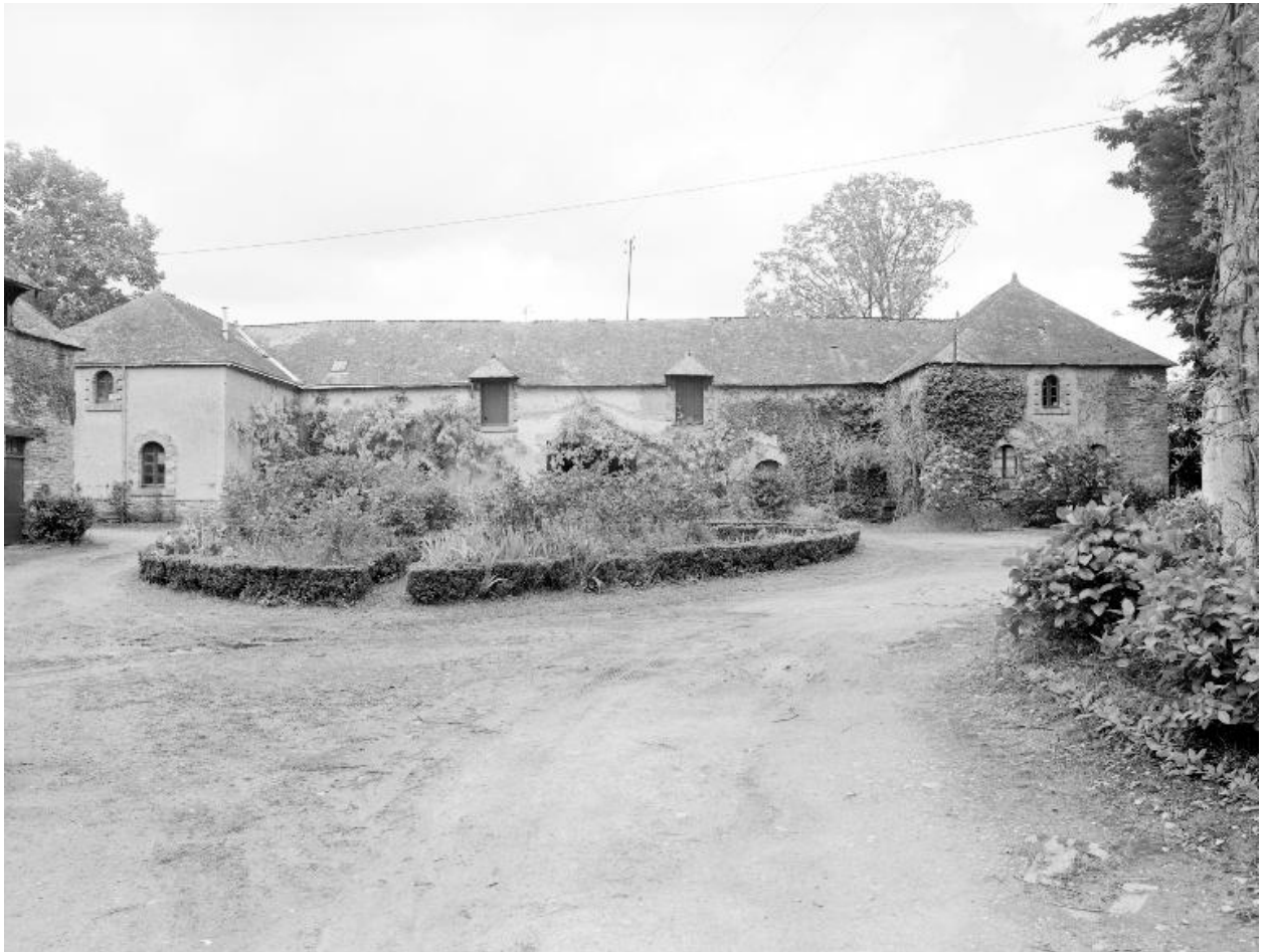
Château : les communs vus du sud (état en 1983)
