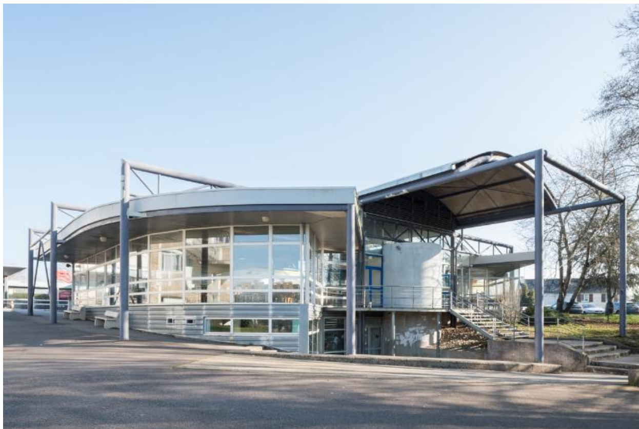
Vue d'ensemble du service de restauration, prise du sud-ouest. Paul Ruelland et Michel Quéré, architectes, 1989.
