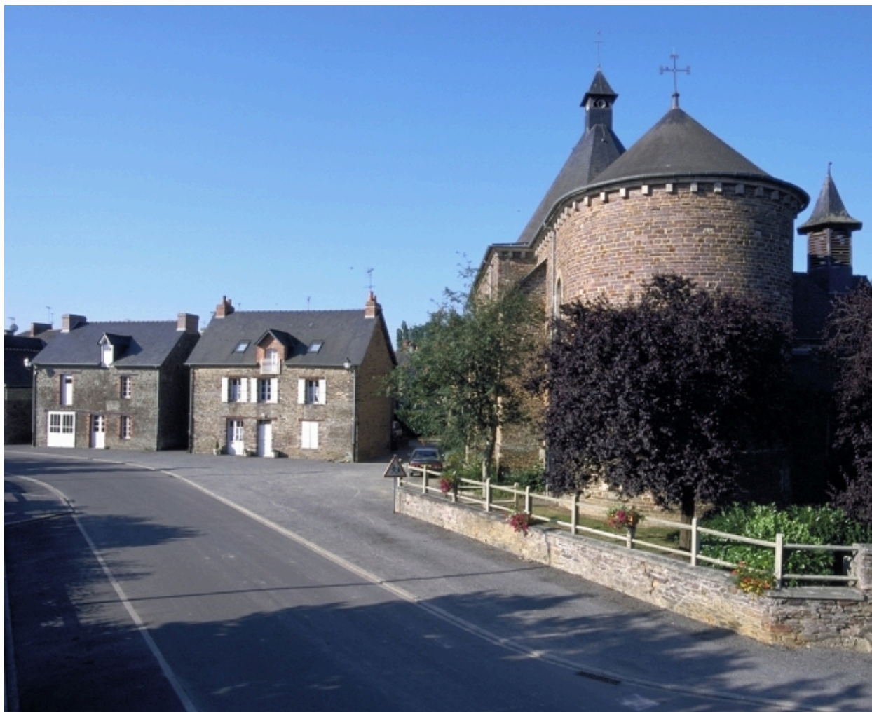
Vue de situation nord-est
