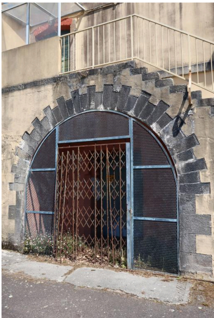
Vue du pignon ouest : baie (état en 2022)
