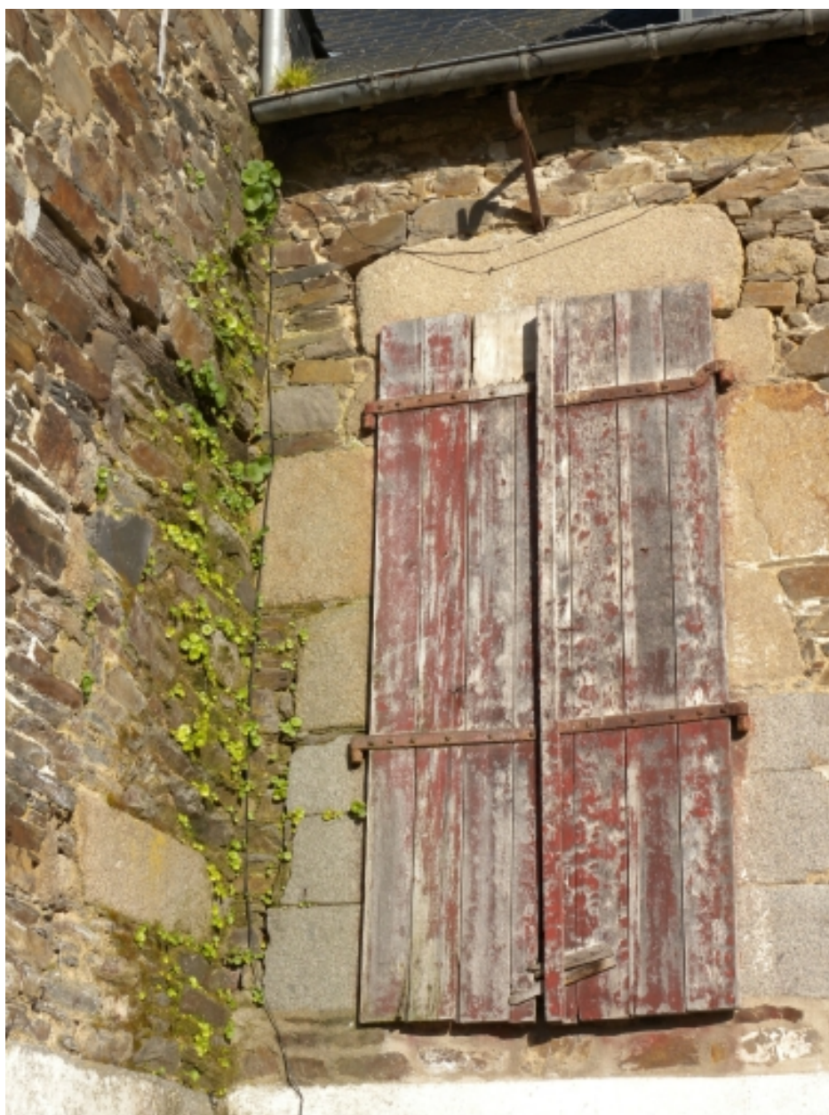
Vue de détail d'une fenêtre avec l'encadrement en pierre de taile (granite)
