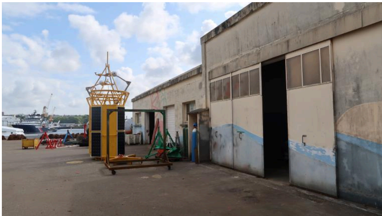
Bâtiment des ateliers
