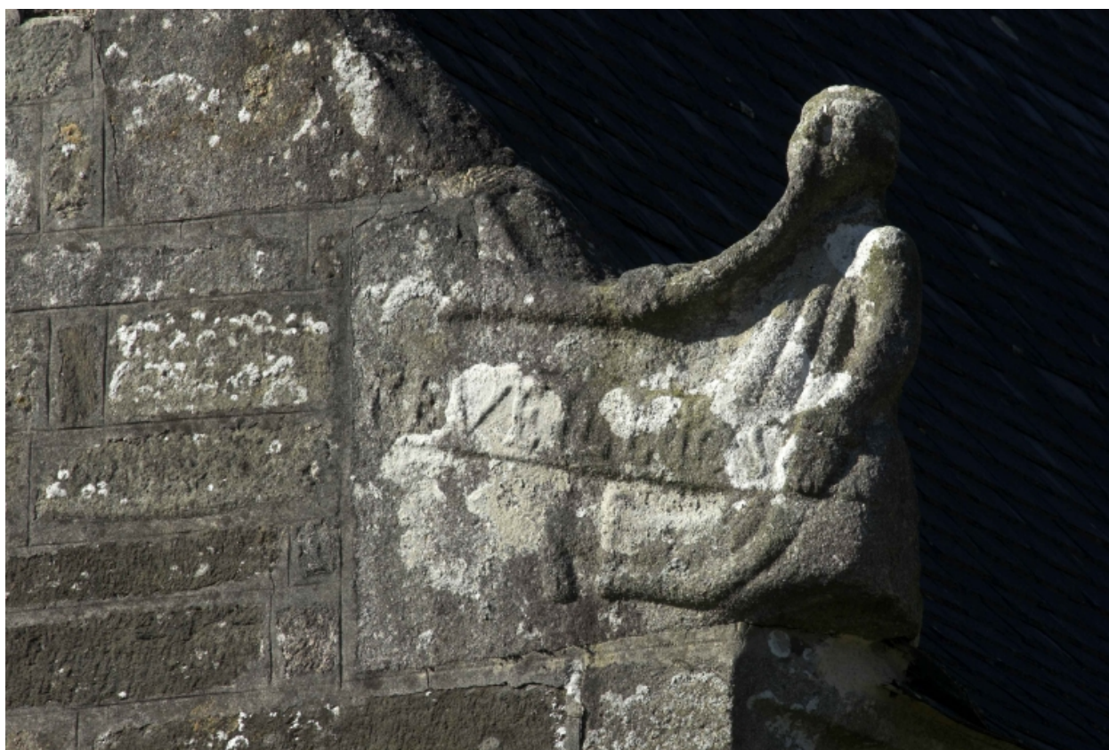
Ossuaire, pignon sud, crossette est
