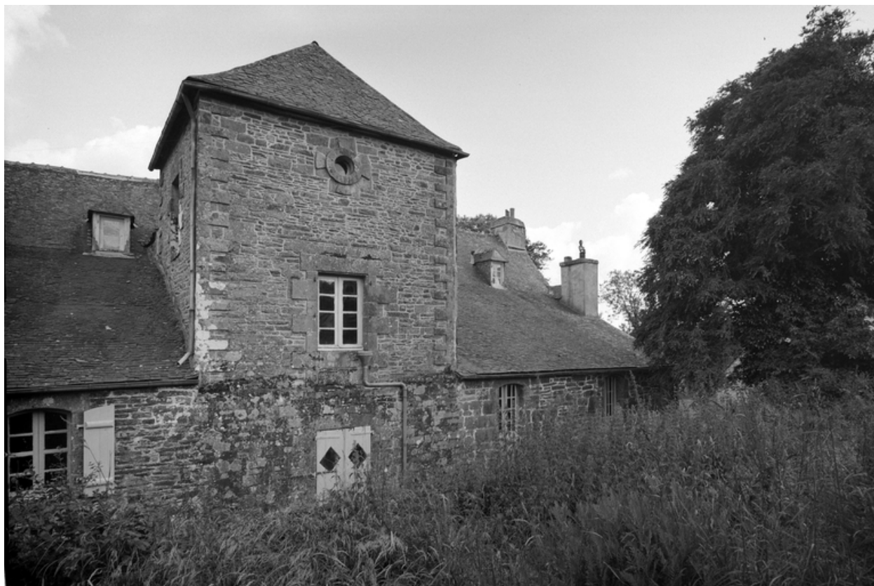
Aile ouest : élévation nord ouest
