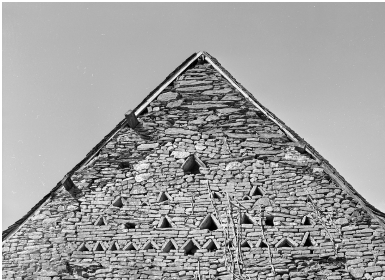
Détail du pignon est.
