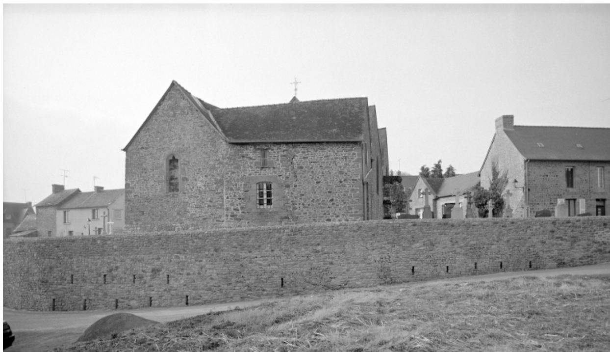
Elévation Est : vue générale
