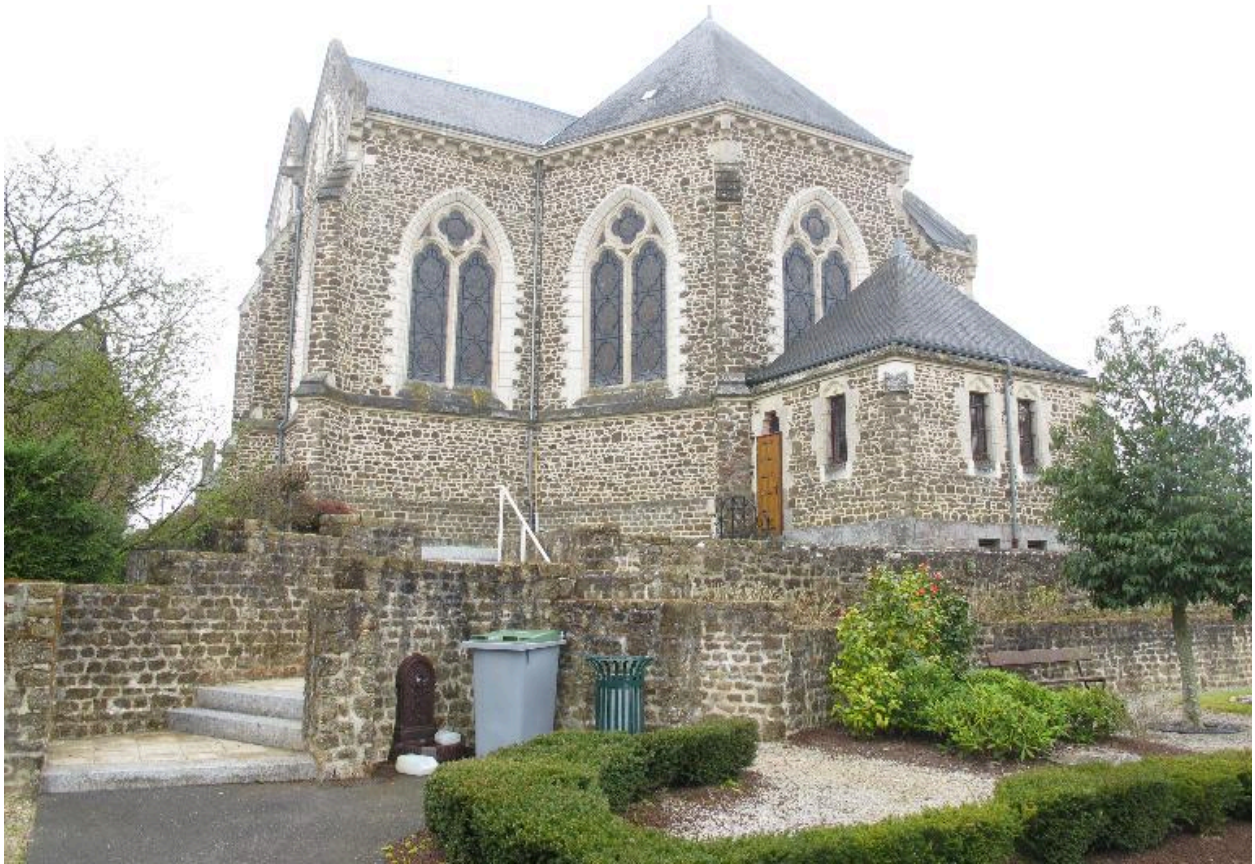
Vue générale : côté Nord-Est
