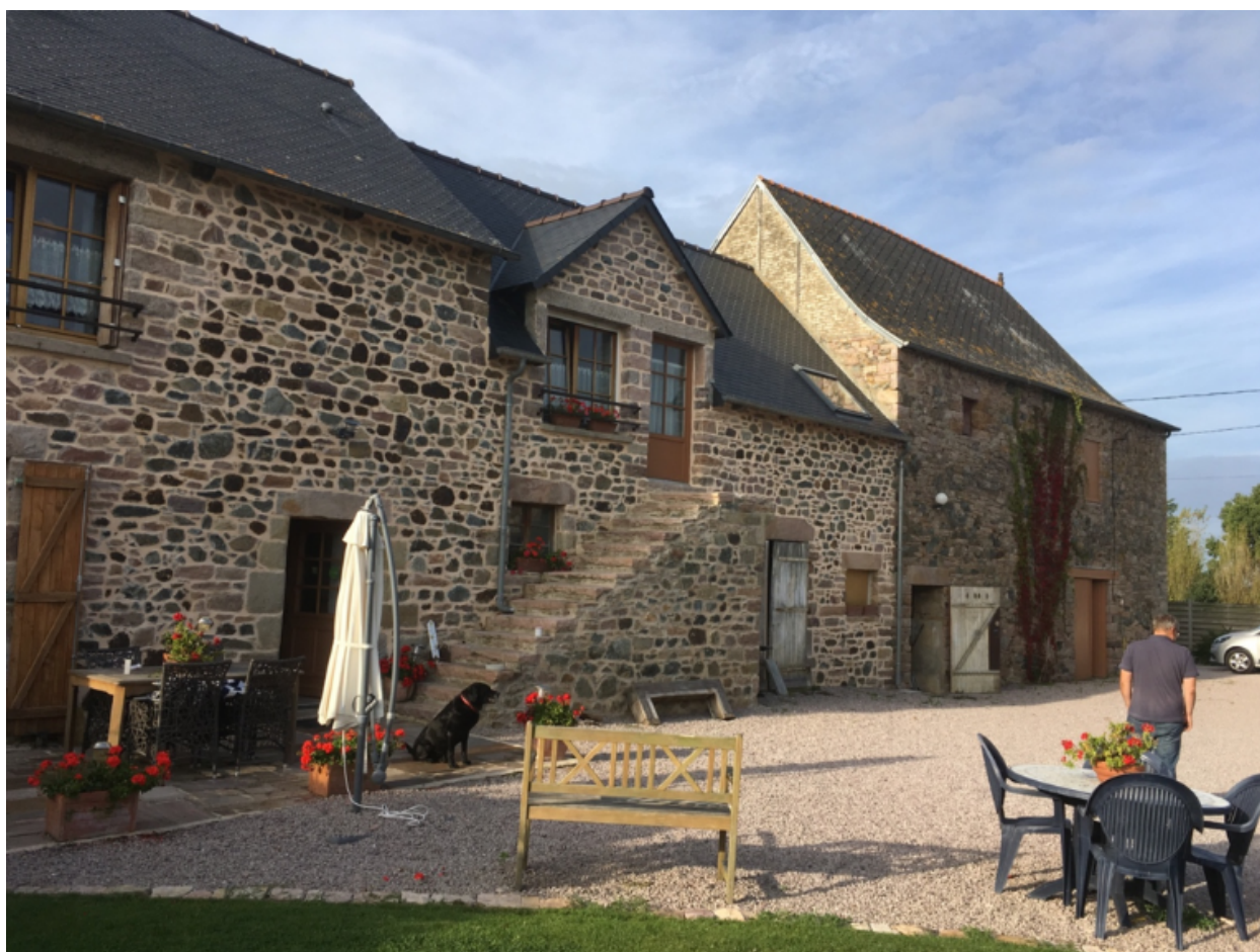
Vue sud de La Moinerie du Portail
