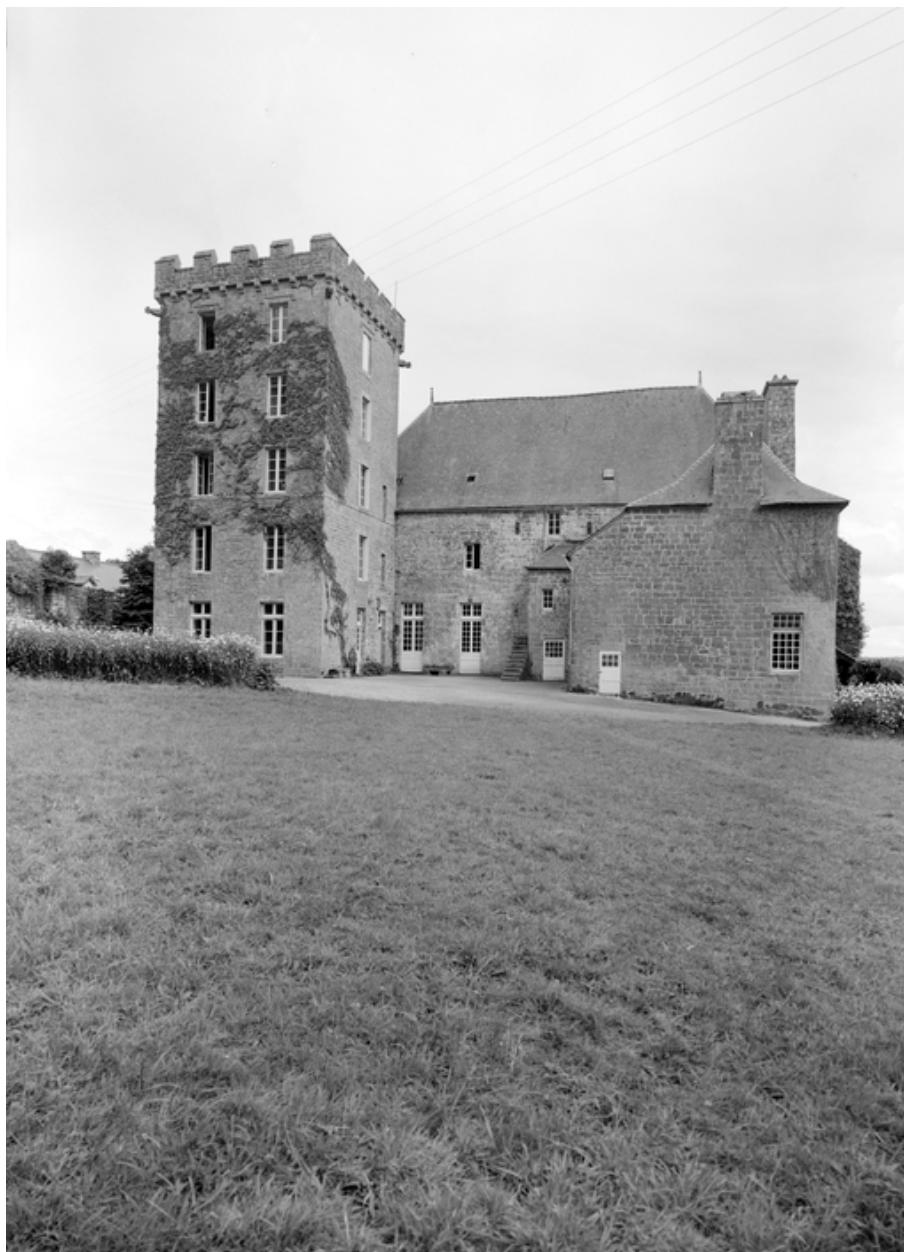
Façade nord, vue générale
