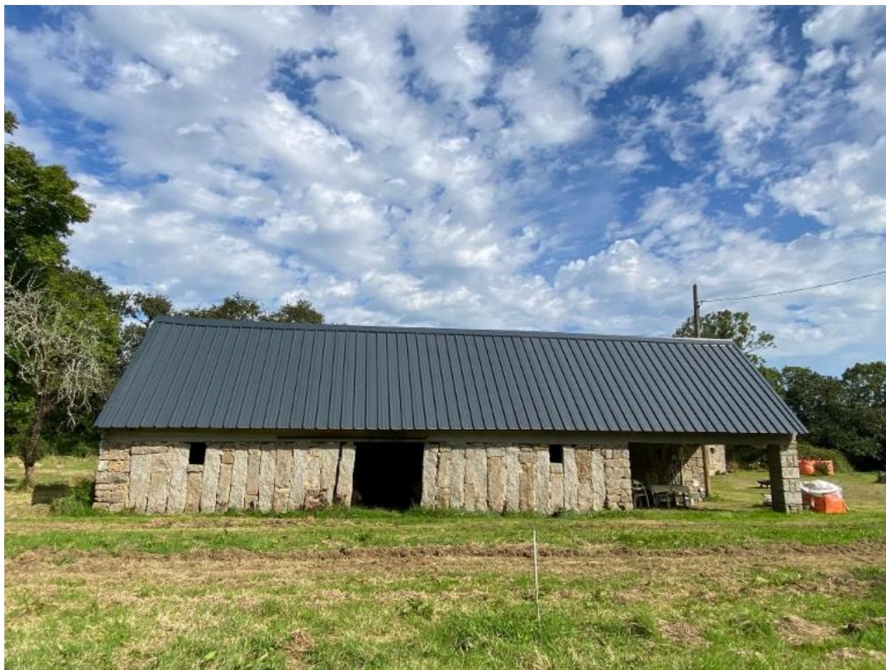
Vue générale de l'élévation sud.
