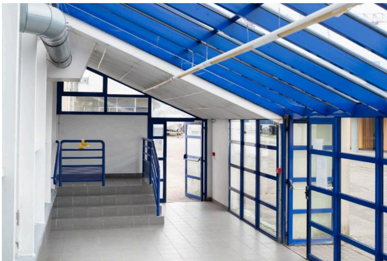
Espace d'attente couvert du self-service de restauration.
