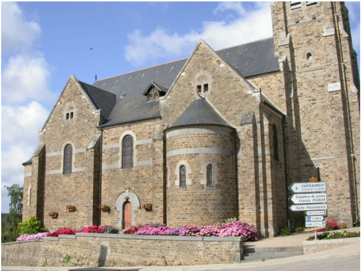
Vue générale de l'élévation est
