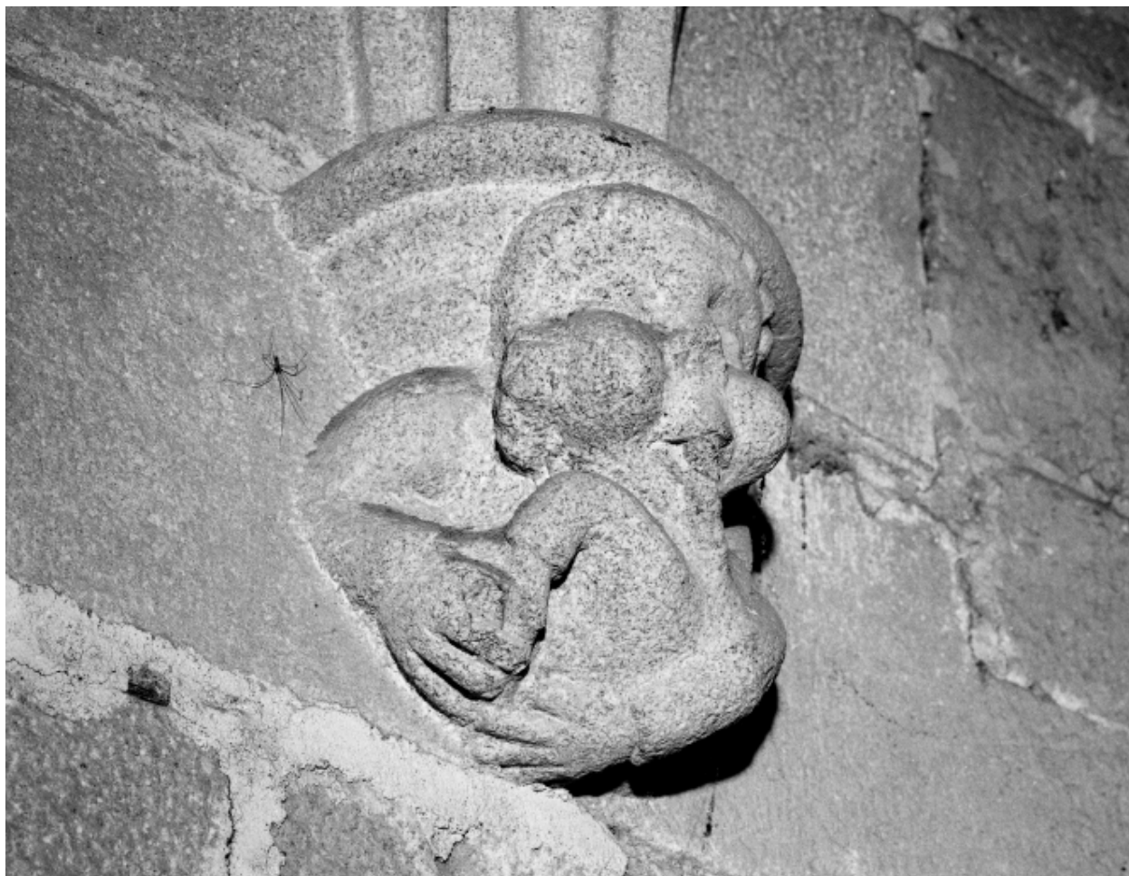
Escalier, 3ème repos du rez-de-chaussée : détail du cul-de-lampe sud est
