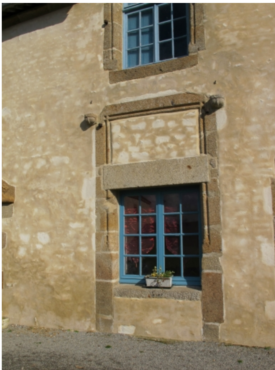
Détail de la façade sud du logis
