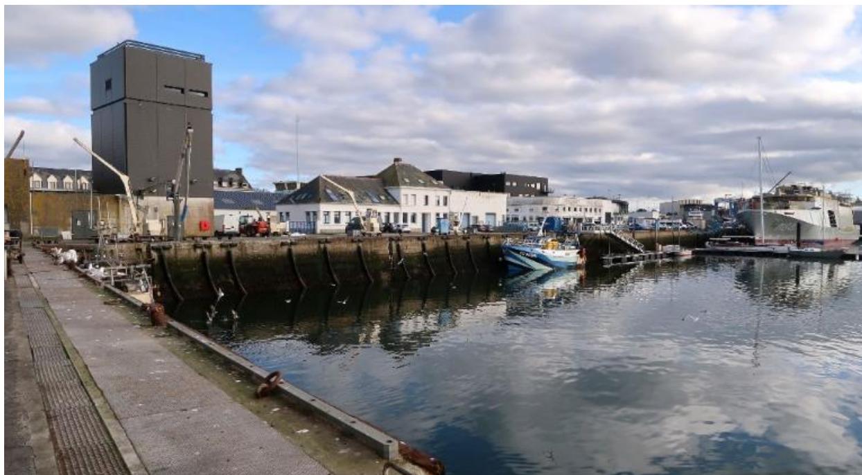
Quai Est : tour à glace et bateaux de pêche accostés à proximité du ponton de Concept Mer et des chantiers Piriou
