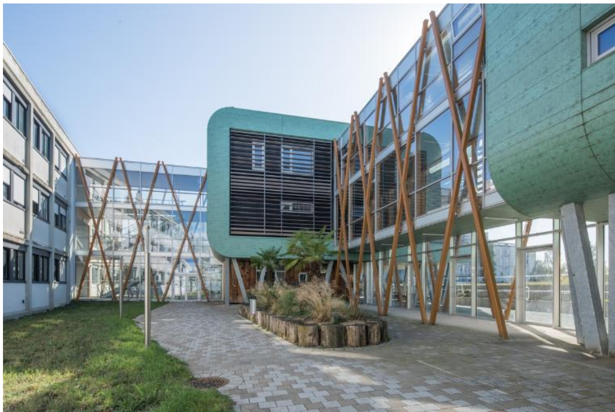
Façade sud de l'externat (B), passerelle de liaison, façade nord de l'espace sciences (B2).
