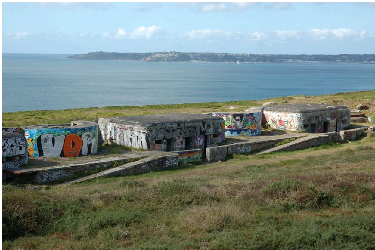
Vue de deux emplacements de pièces et de deux magasins de combats (état en 2007)
