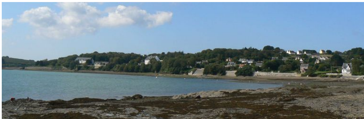
Vue générale de l'espace portuaire et militaire de Quéléren
