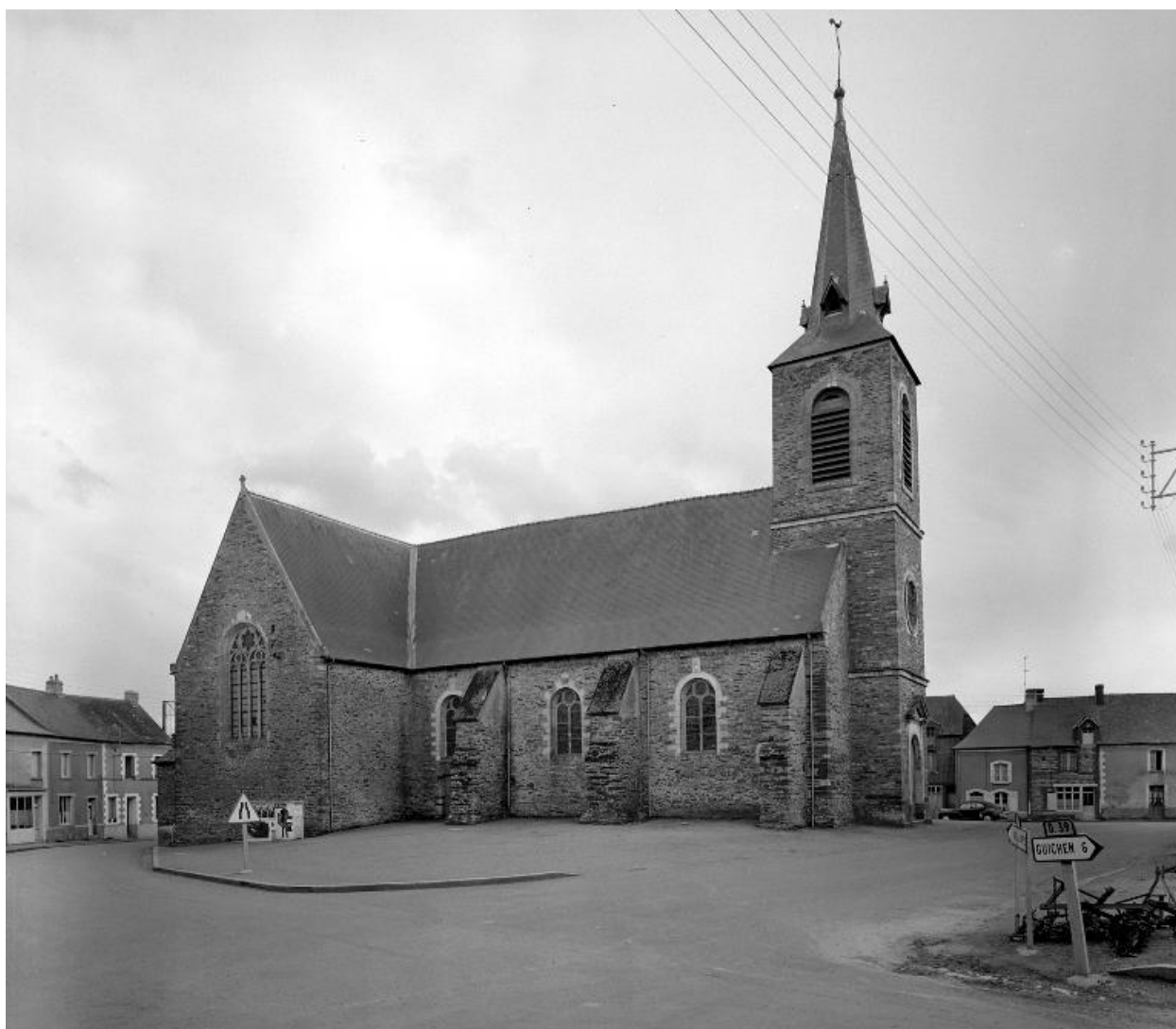
Elévation Nord : vue générale (Etat en 1968)
