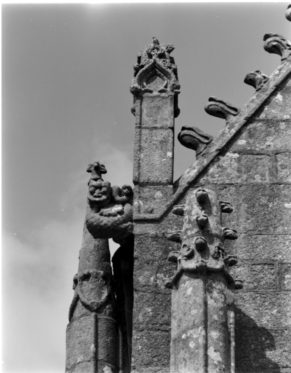
Porche sud, détail : pinacles de l'angle sud-ouest
