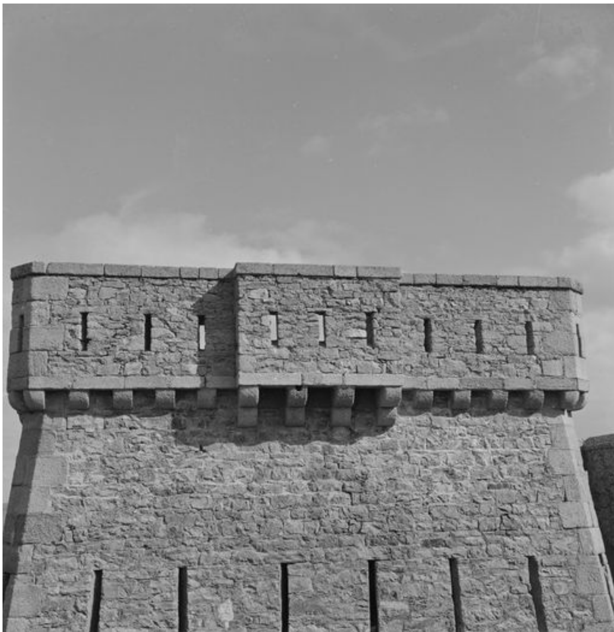
Camaret-sur-Mer, pointe du Toulinguet : vue de la tour-modèle n° 3 en 1969, créneaux de fusillade de type archère, mâchicoulis ou créneaux de pied, bretèche
